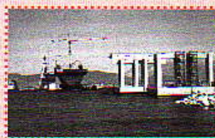
Οι μεγάλοι πυλώνες της ζεύξης Ρίου-Αντιρρίου και στο βάθος ο μεγαλύτερος γερανός του κόσμου, ο «Τάκ-Λίφτ», ανυψωτικής ικανότητας 1.200 τόν.
